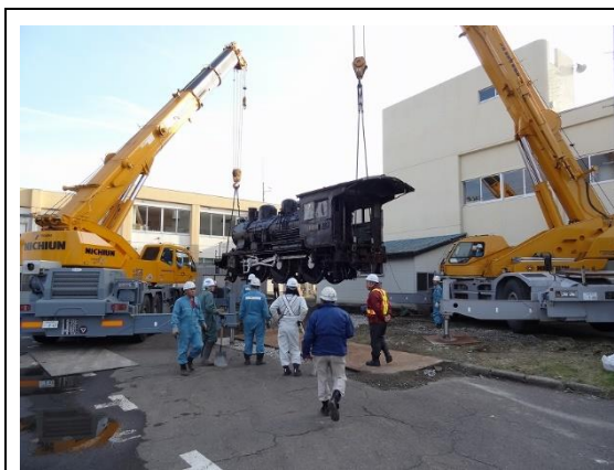
写真1 車体をそのまま吊上げた例
