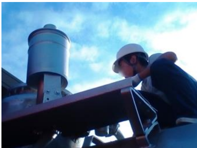
▲安全弁の取付を終えてボルト締めを確認中
