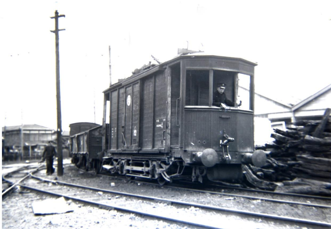
▲写真2 昭和11年 鷹匠町の貨物側線へ入るデ12+トコ+有蓋車(保存会所蔵) 当時貨物列車として運行されていたことがわかる写真。 現状のデワとトは貨物関係の車票差しなどが撤去されている。
